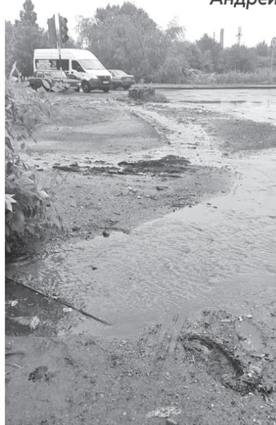
– К сожалению, гидромашина из Луганска не помогла решить проблему. Канализационная труба разложилась, мы начали рыть со стороны улицы Спортивной, куда идет коллектор, и дальше сточные воды попадают на очистные сооружения. Точные сроки завершения ремонтных работ назвать затруднительно, поскольку сначала надо найти уцелевший конец трубы, чтобы присоединить к ней и проложить новую канализацию.
