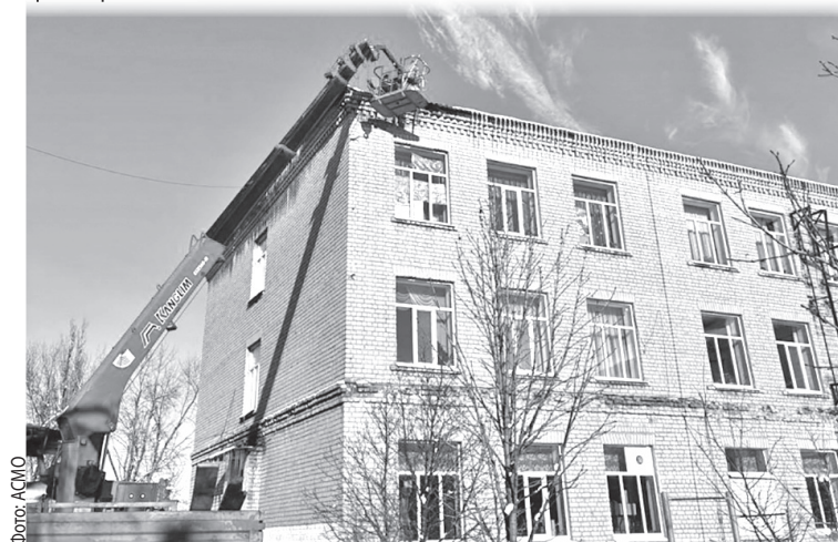
► Ремонт кровли школы в Червонопартизанске
