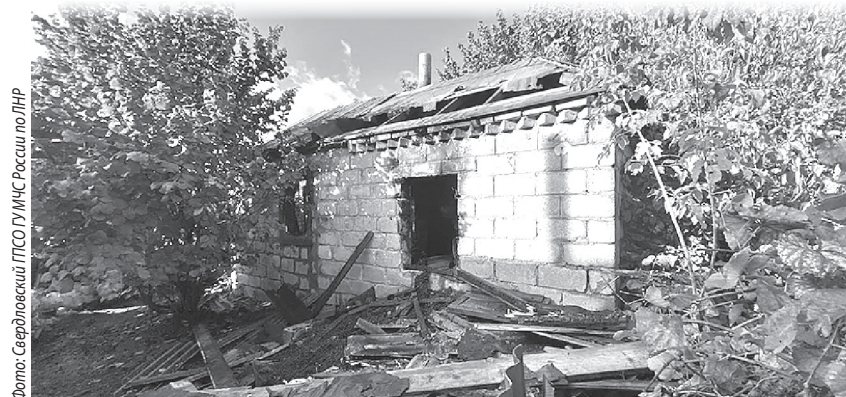
► Последствия пожара на ул. Кутузова
