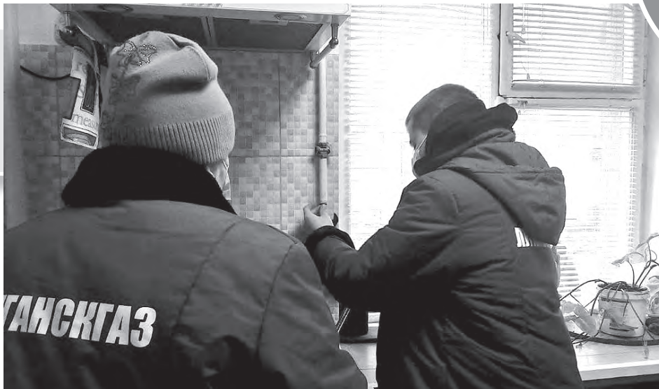
► 18 февраля специалисты горгаза в кв. 50 лет Октября проверили в квартирах абонентов оборудование, наличие тяги в дымовых и вентиляционных каналах
