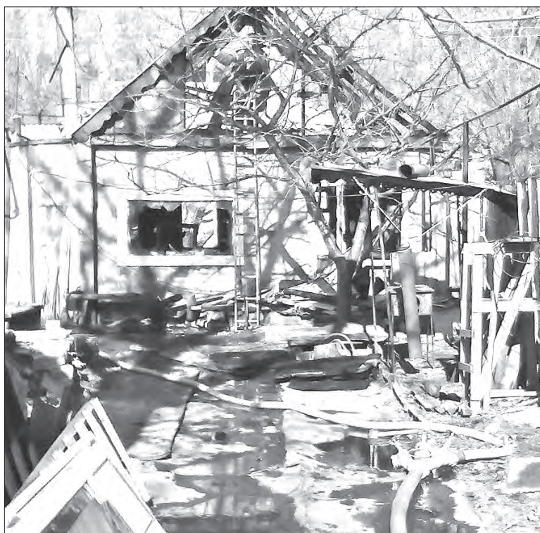
После пожара на ул. Украинская
