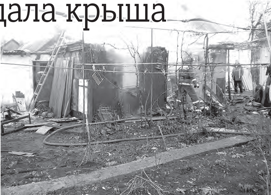
► Последствия пожара на улице Леваневского
