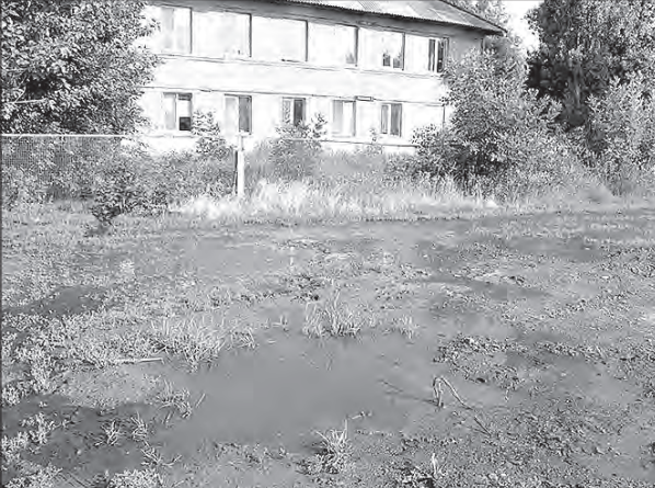
► Эта фотография сделана утром 15 июля, до начала ремонтных работ
