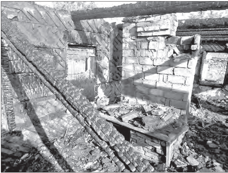
► Последствия пожара на ул. Пугачова
