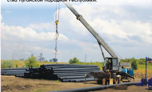
На решение «водных» вопросов и направлены работы по капитальному ремонту аварийного участка магистрального водовода диаметром 500 мм от повысительной насосной станции № 114 в г. Артемовске до пгт. Байрачки, которые стартовали 4 августа.
