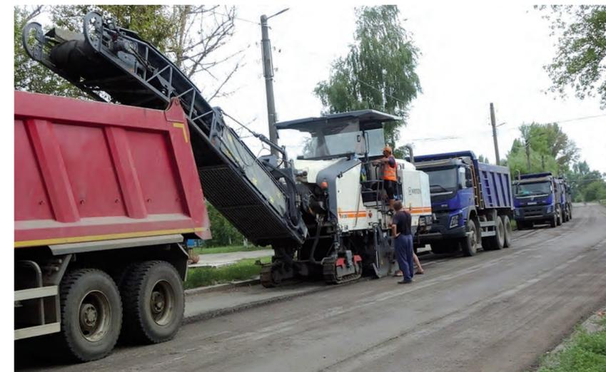
На трассе Т13-14 в Беловодске ведутся ремонтные работы. Идет процесс демонтажа изношенного асфальтового покрытия.
