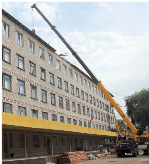
В поселке Новопсков быстрыми темпами в здании поликлиники идет процесс замены кровли. Работа масштабная – ведь общая площадь крыши 1200 квадратных метров! Поэтому работы выполняются одновременно в двух направлениях – заканчивают демон-
