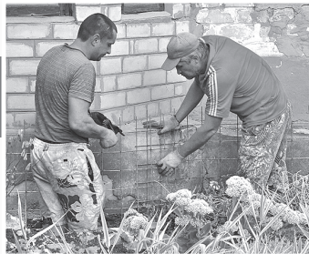
Идут работы по обновлению фасада здания
