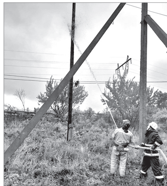
► В Свердловске на ул. Куприна горела электроопора
