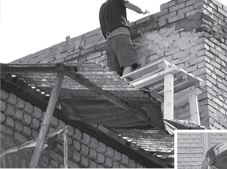
Крыши спешат отремонтировать до дождей
