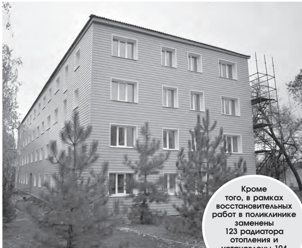
Кроме того, в рамках восстановительных работ в поликлинике заменены 123 радиатора отопления и установлены 104 оконных блока.
