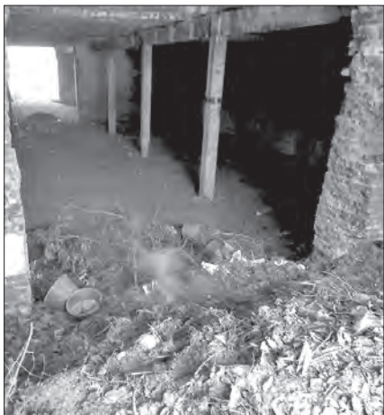
► В Свердловске в районе ул. Линейная горел мусор в брошенном здании
